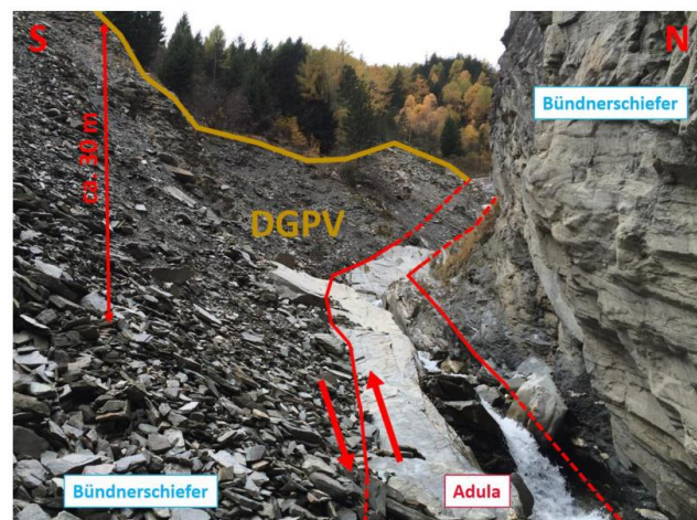
Piede del dissesto lungo l'alveo del riale
