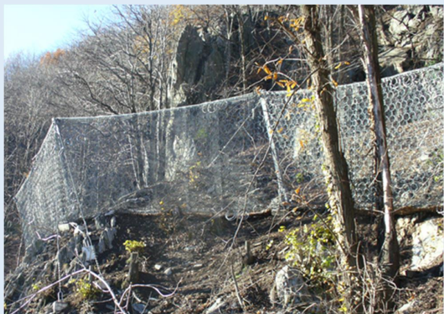
Dettaglio fila superiore (Geobrugg RXI-300, 3'000 kJ)
