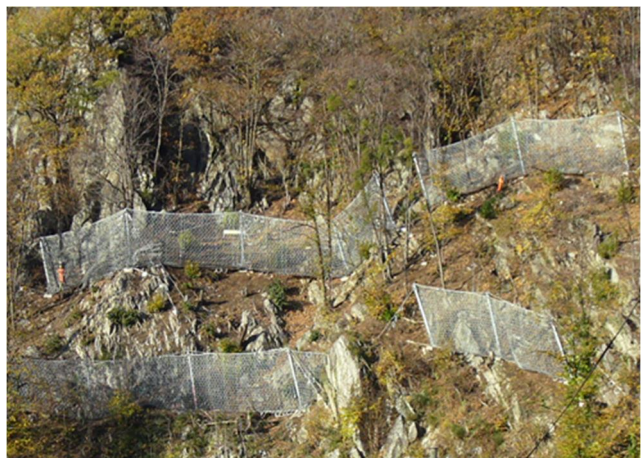
Vista d'insieme delle reti paramassi (file superiori)
